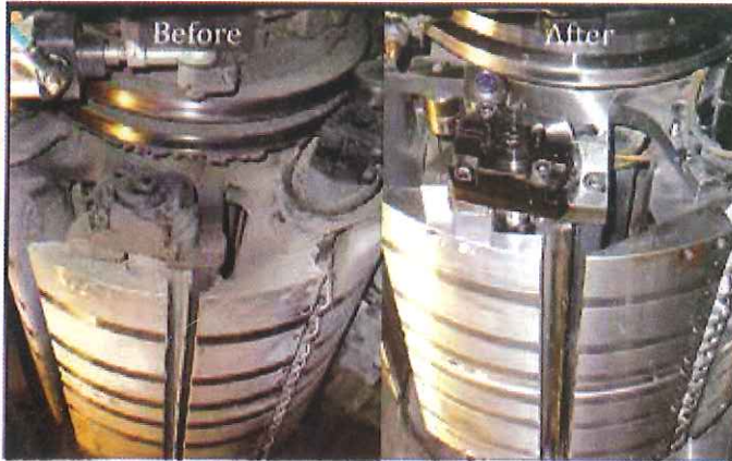
إزالة الطلاء والتآكل Coating & Corrosion Removal
